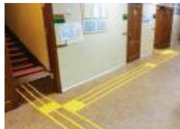
Специальные объемные тактильные плитки и другие варианты напольных покрытий (например, встраиваемые направляющие полосы и биты) формируют рисунок, позволяющий незрячим людям получать информацию о безопасном пути движения (направления движения, повороты) и о наличии препятствий на пути движения (пороги, перекрестки, ступени, лестницы, столбы или колонны, двери, пешеходные или подземные переходы).
